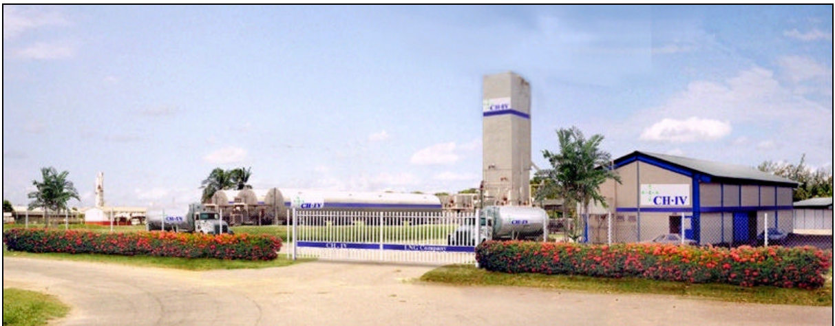
Modular LNG Production Facility
