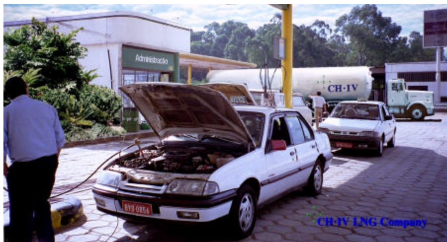
LNG Transport Trailer Leaving LNG to CNG Fueling Station
